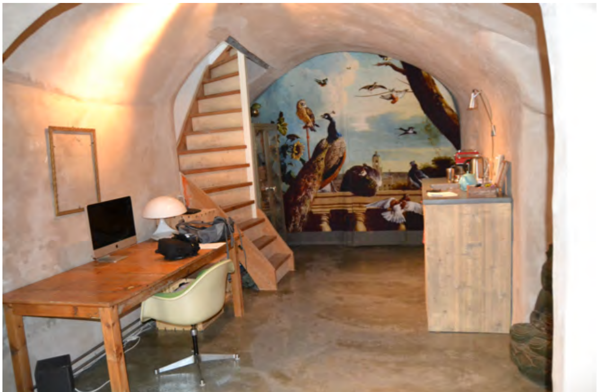
Foto uit 2017 waarop te zien is hoe de trap gerealiseerd is in de keldermuur. Bij de muur zit op het hout oranje menie.
