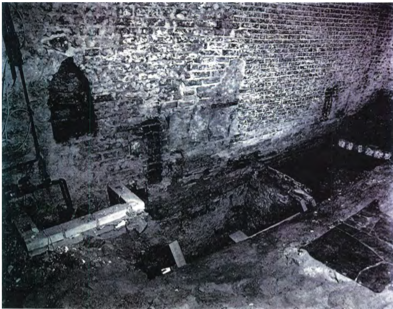
1995: Oudegracht 230 begane grond; nadat het zand was verwijderd en het keldergewelf opengebroken is, waardoor een doorgang ontstond tussen de kelder en de begane grond.
