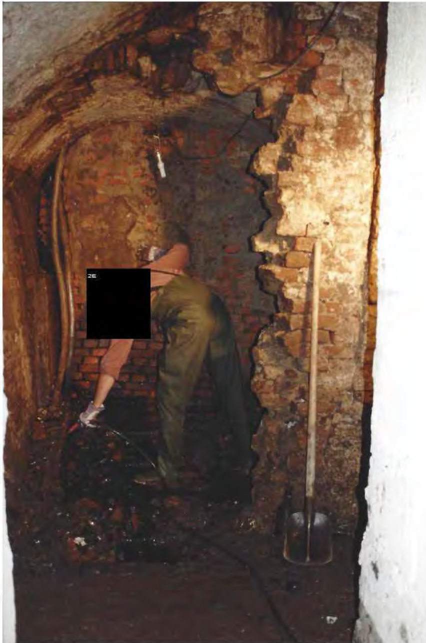
Foto uit 1999 van de kelder Oudegracht 230 waarop wordt aangetoond dat: waar de steunpilaar en dwarsmuur in de kelder van Oudegracht 230 zich bevond en dat de steunpilaar net achter de gesloopte dwarsmuur stond. Die steunpilaar staat op de foto rechts in het wit/grijs weergegeven.
