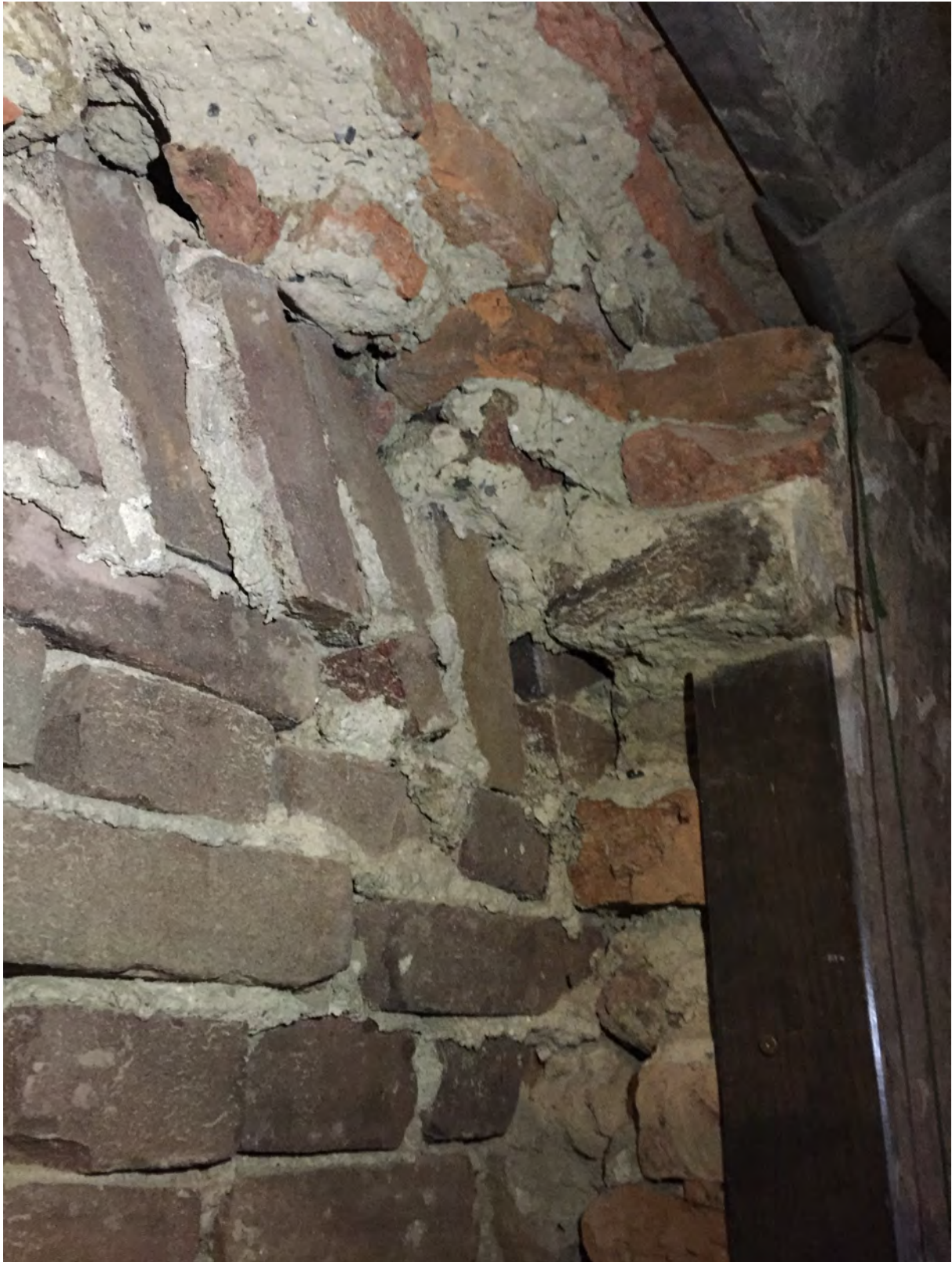
Foto van de keldermuur dat aantoont dat het bakstenen gedeelte onder het (oudere) bovenste gedeelte van de keldermuur staat en dus een constructieve functie heeft ten aanzien van de rest van de constructie van Oudegracht 228 en Oudegracht 230. Op deze foto is eveneens te zien wat de dikte van het kloostermoppengedeelte is, namelijk 15 cm, en het bakstenengedeelte van de keldermuur 21 cm dik is. Beide delen staan onder de rest van de keldermuur.
